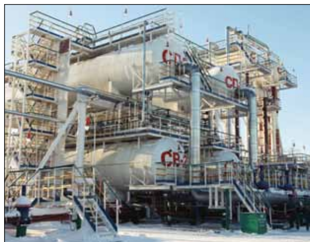
Сепаратор CPF на Восточно-Салымском месторождении
