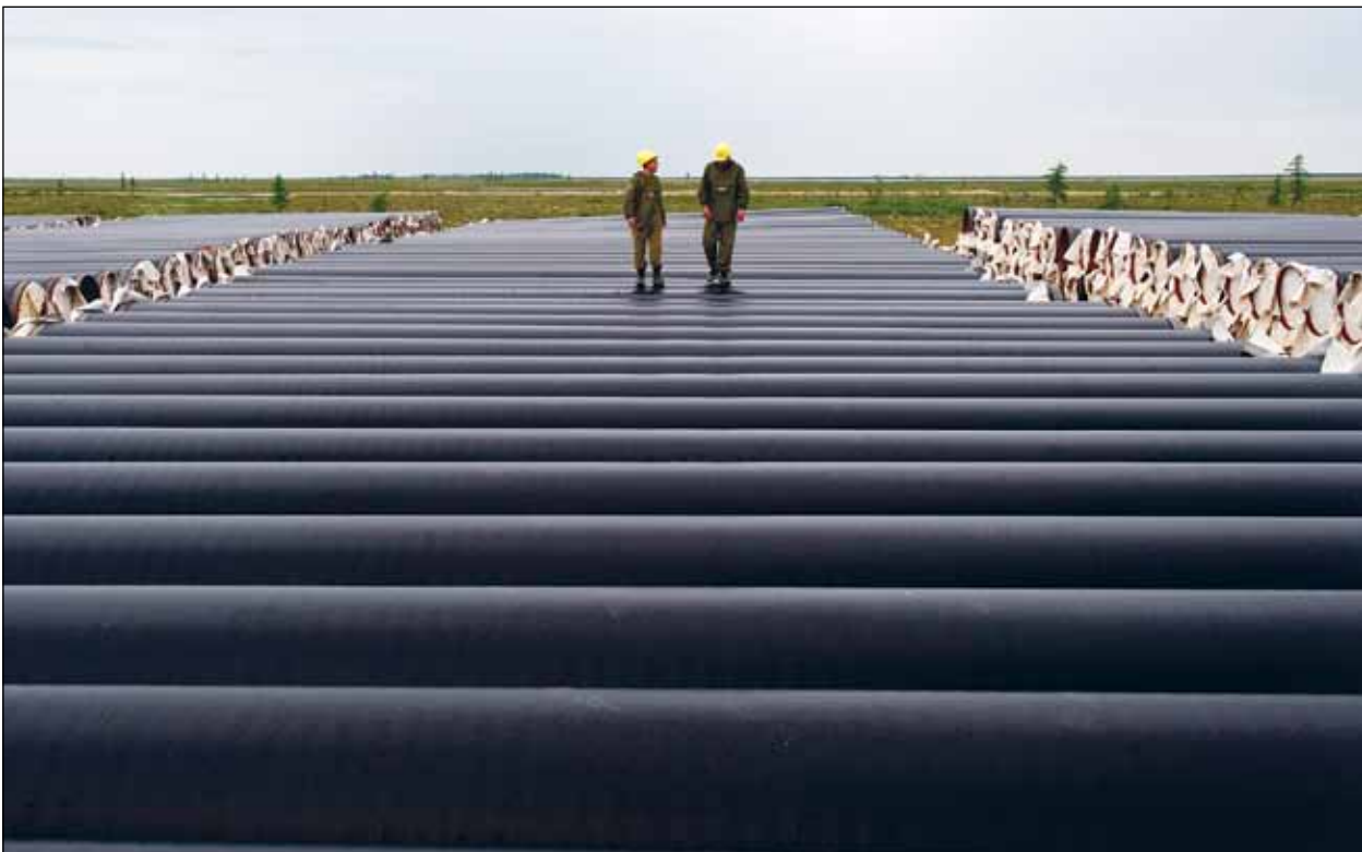
«СеверЭнергия», газовые трубы
