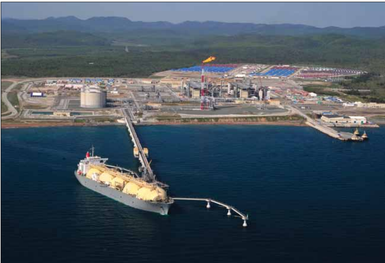
Завод СПГ проекта «Сахалин-2»
