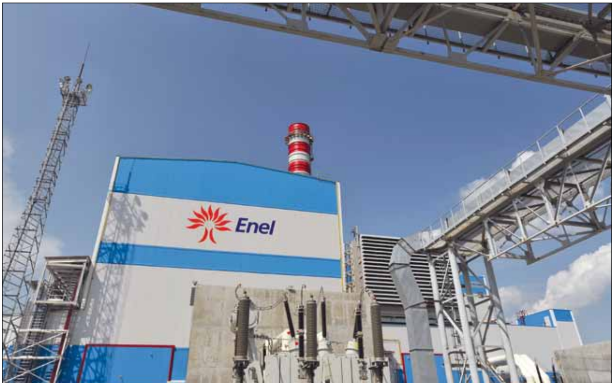
Новая парогазовая установка с установленной мощностью 410 МВт, введенная в эксплуатацию Председателем Правительства РФ В.В. Путиным 25 июля 2011 г. на филиале Среднеуральская ГРЭС ОАО «Энел ОГК-5», входящем в группу компаний Enel
